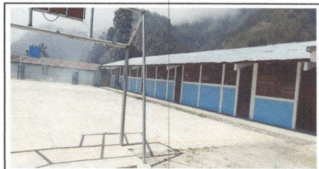
Foto 6: Fabricación e instalación de ventana-balcon de metal
