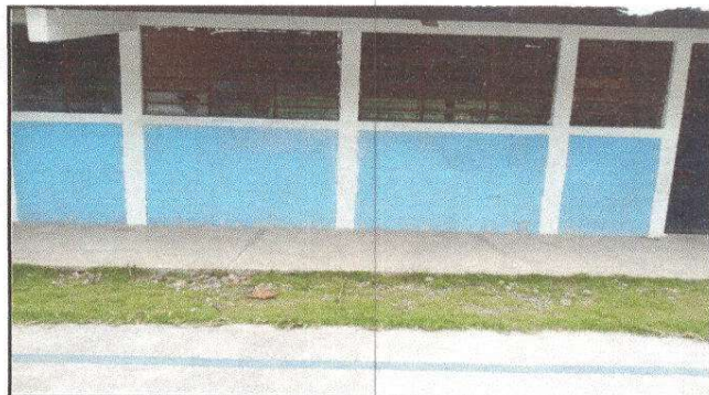
Foto 4: Fabricación e instalación de ventana-balcon de metal
