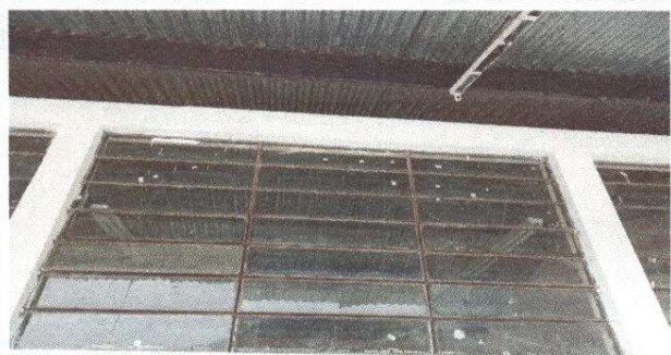
Foto 3: Fabricación e instalación de ventana-balcon de metal
