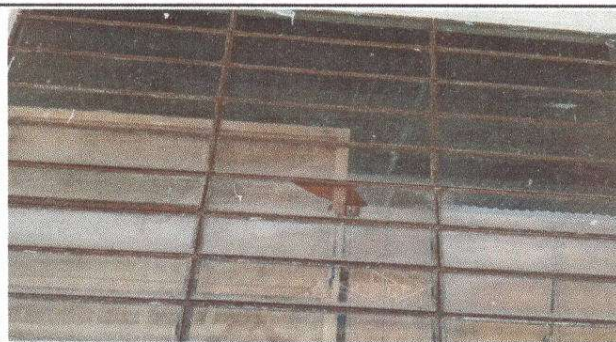
Foto 5: Fabricación e instalación de ventana-balcon de metal
